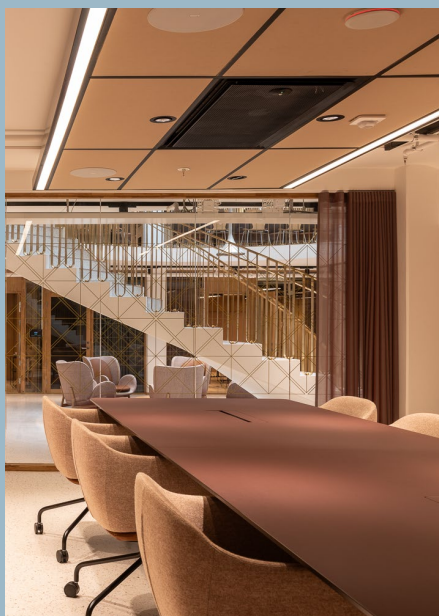
Himlingsflåter etter arkitekts tegninger med integrert belysning
