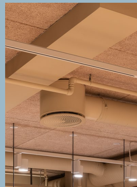
Gjenbruksventilasjon Åpen himling
